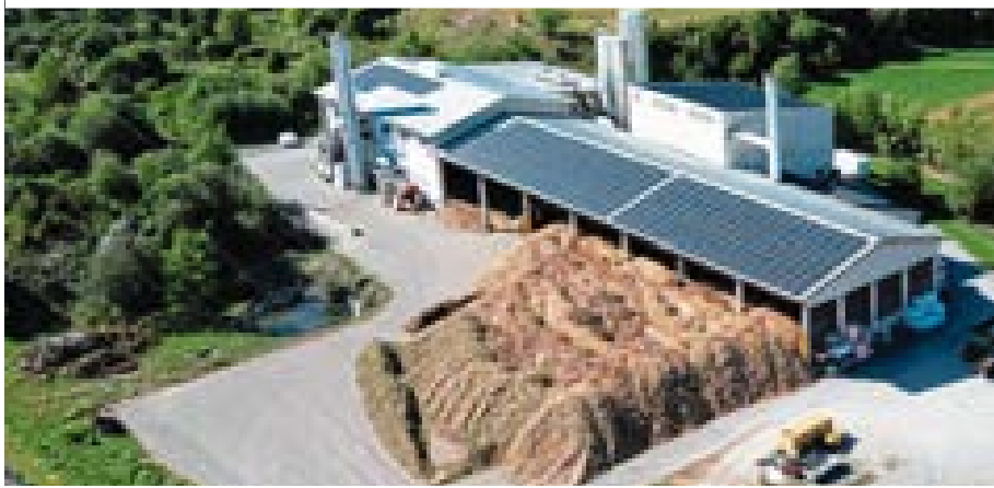
Die Biomasse-KWK-Anlage in Schwarzau am Steinfeld sorgt für nachhaltige Energie
